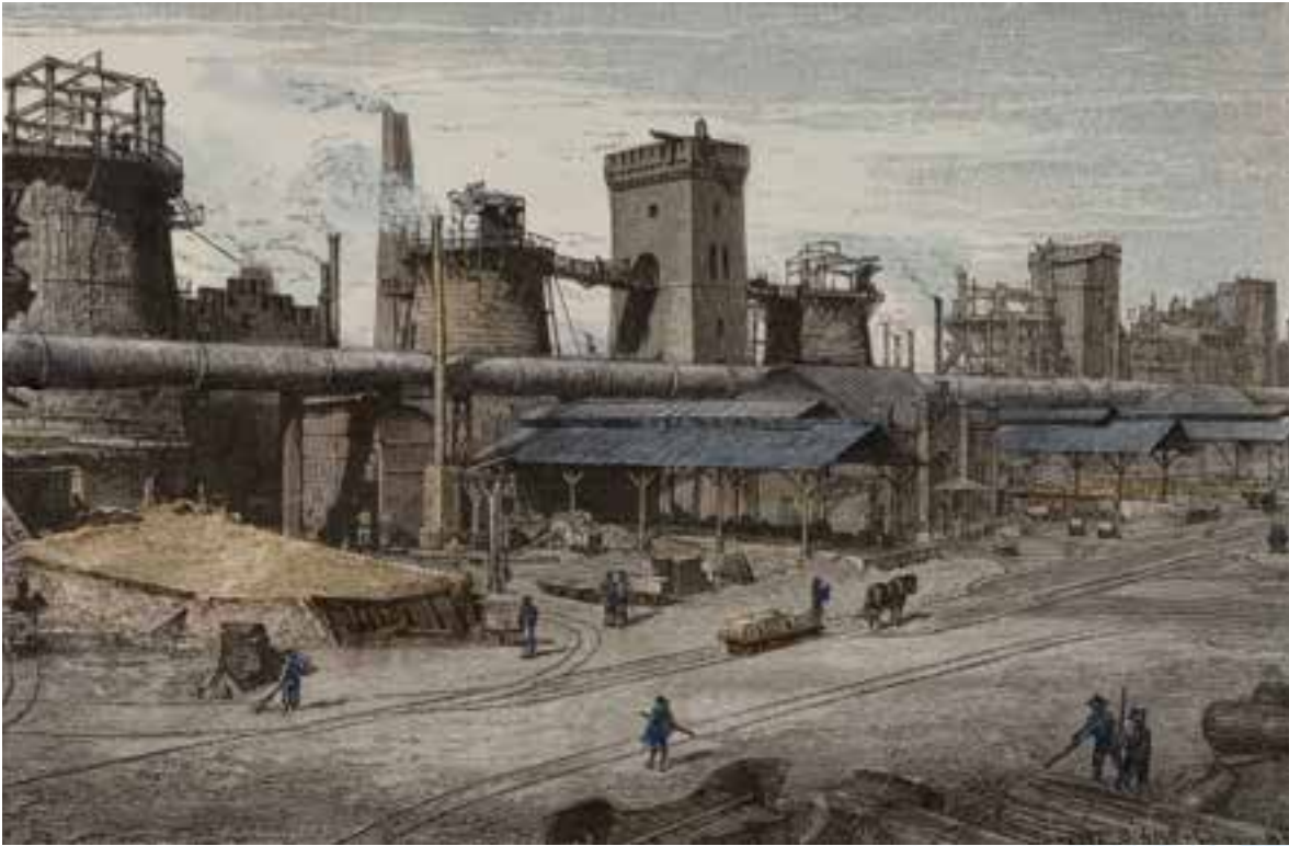
„Hochofenanlage in Koenigshuette.“ Kolorierter Holzstich, Zeichnung von Blätterbauer, aus: F. Schroller: Schlesien, Bd.III, S. 28, 1888 © Stiftung Kulturwerk Schlesien
