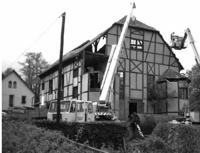
Beginn der Abbau- und Sicherungsarbeiten am Bethaus Schönwaldau, Kr. Goldberg. Aufnahme: Stefan Barnowski.
